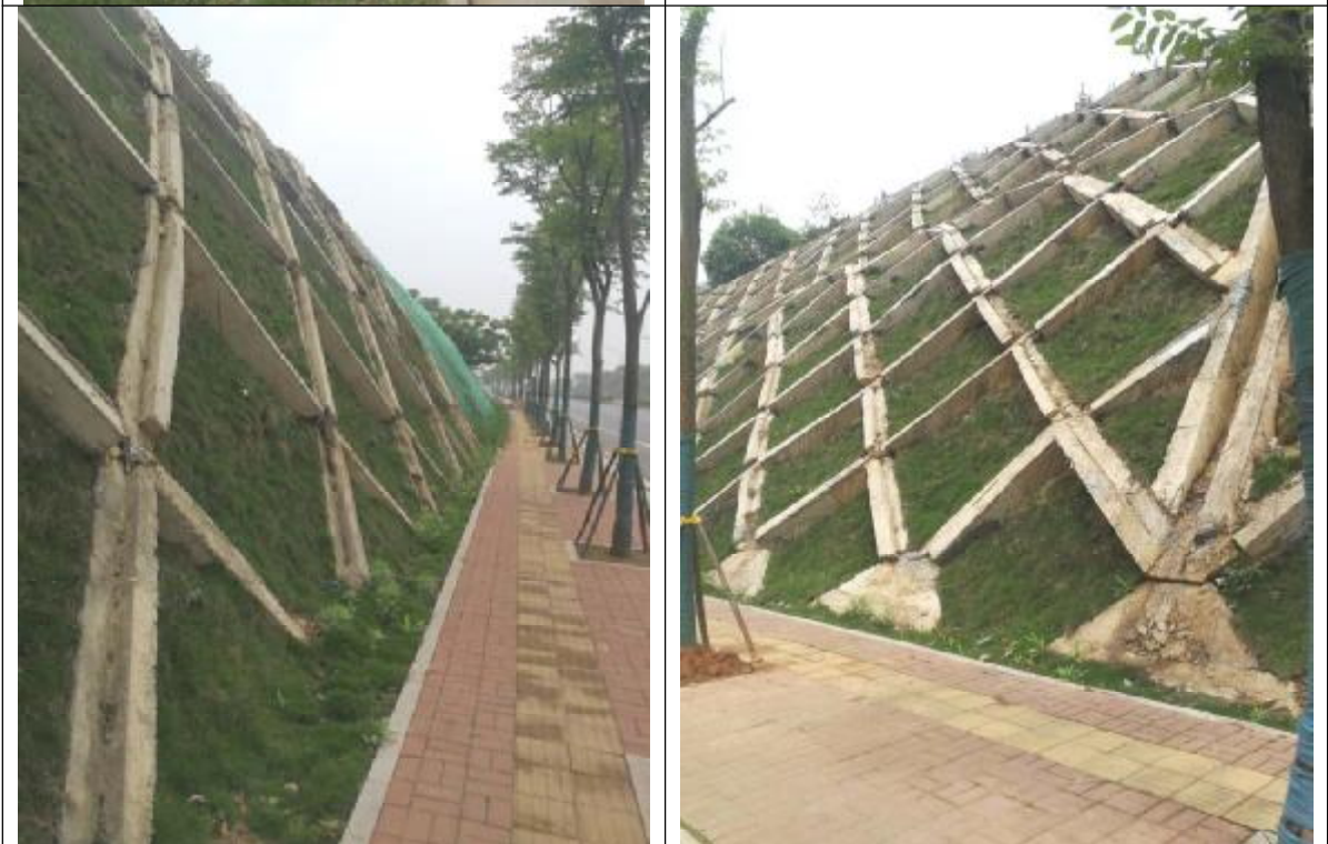
竣工高边坡现状
