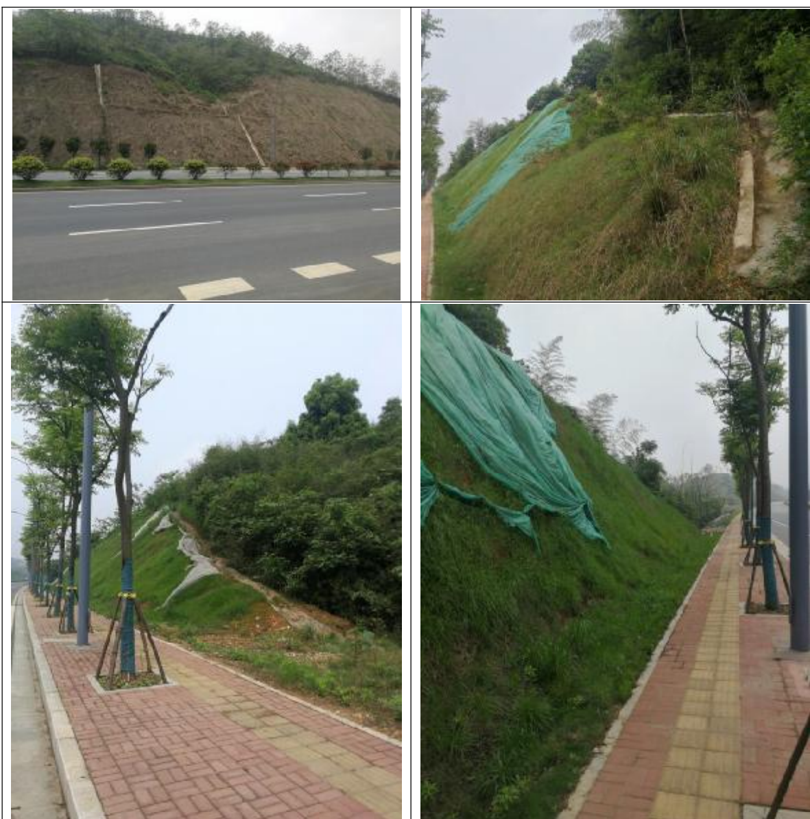
截、排水沟现状
