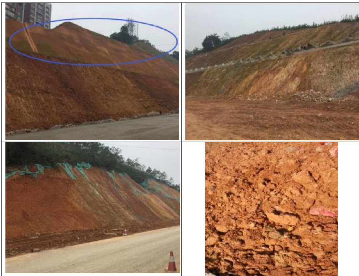
施工期间现场照片
